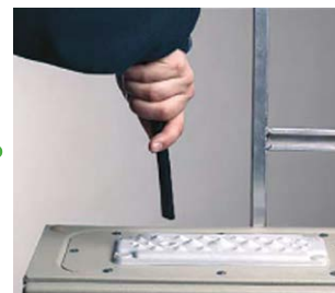
Schieben Sie das Kabel oder Rohr durch die Führungsbohrung.
